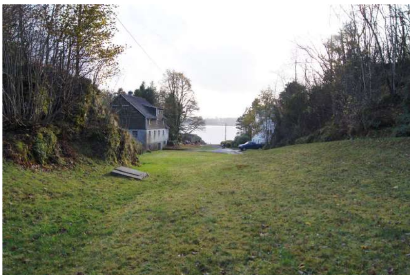
Figur 66. Tunet på Mjåtveitstøen sett frå nord.
