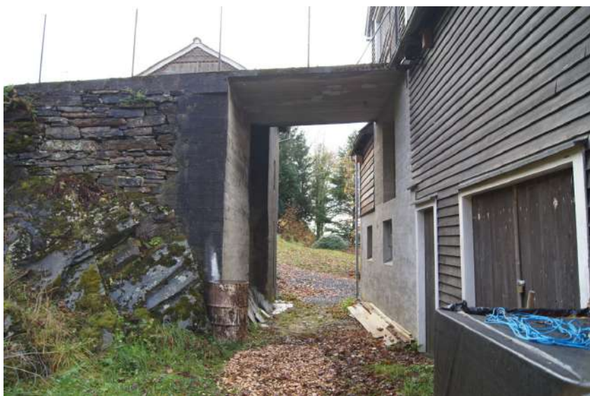
Figur 73. Løa på Mjåtveitstøen, låvebru mot aust.
