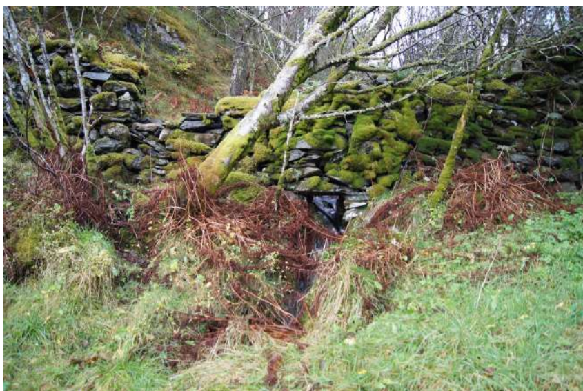
Figur 95. Steingarden til innmarka på Mjåtveitstøen på vestsida, sett frå innsida ved hol til bekk.
