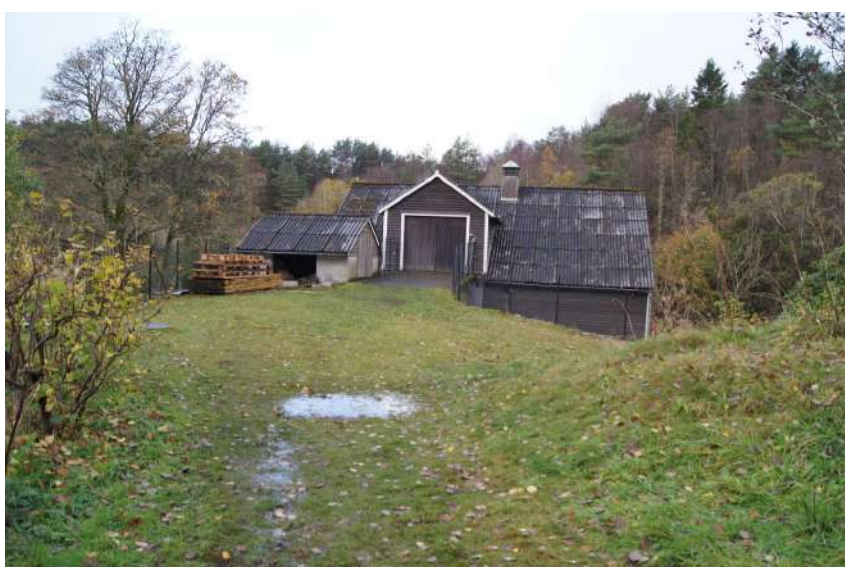
Figur 74. Løa på Mjåtveitstøen, fasade mot aust.
