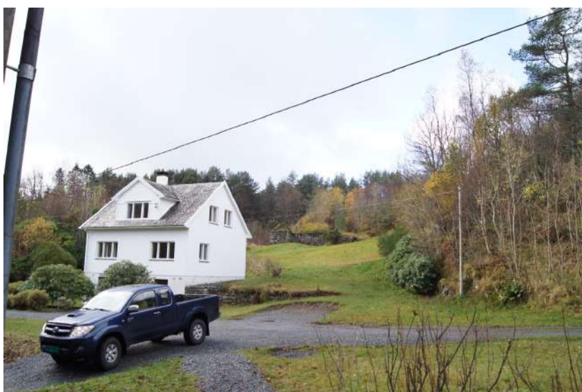
Figur 71. Våningshuset på Mjåtveitstøen, fasade mot aust og nord.
