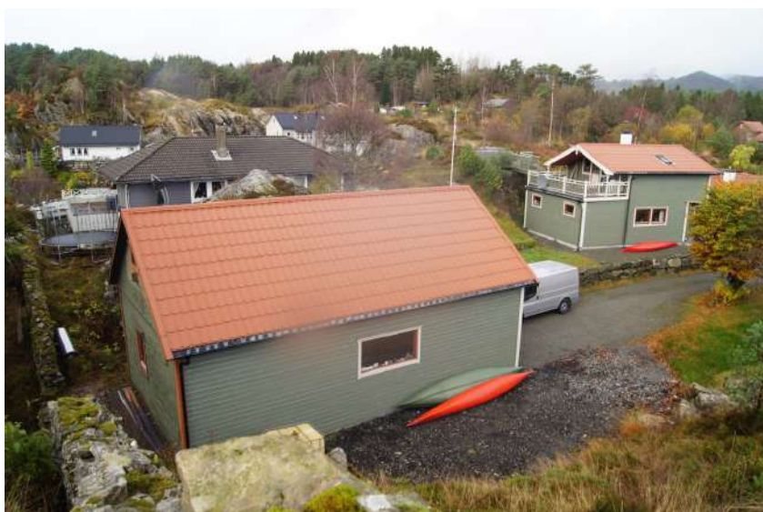
Figur 46. Mjåtveitstø 14 i forgrunnen. Bak i grått ligger Mjåtveitstø 32, og bakerst kan ein skimte Mjåtveitstø 35, 33b og 33a.
