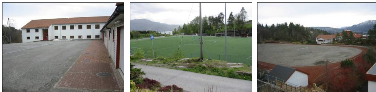
Bileta viser (f.v.): Skuleplassen bak bygget, kunstgrasbana og friidrettsbana på oppsida av bygget.
