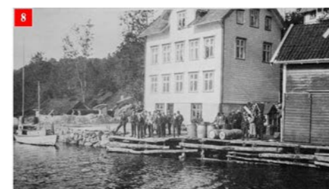
Stenekaiaen og butikken Tidlegare hurtigbåtkai, før den vart flytta til kaia ved Lindås Brygge. I huset på kaiaen var bakeri i kjellaren og butikk i 1.etasje. Bustad i etasje over. Bak sjøhuset til høgre låg det første meieriet på Lindås. Huset er i dag privat bustad, medan kaiaen bortom er kommunal.
