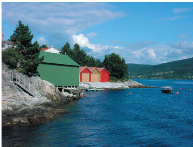
Naustmiljø ved Knarvik kai. Her kunne ein legge ein strandsti langs og mellom nausta.
