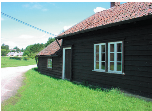
Gamlestova på Tveiten er ein av fleire gamle bygningar ein passerer dersom ein parkerer bilen i Alversund for å gå vidare på tur til Tveitamarka.
